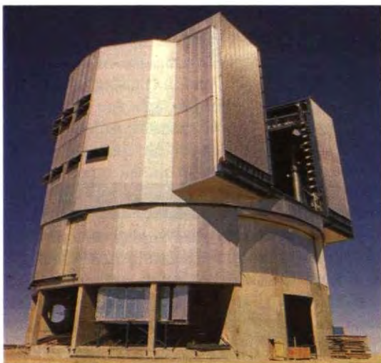
Paranalas observatorijas VLT 8,2 metru Antu teleskopa tornis ar atvērtu "kupola" 10 metru plato spraugu. Līdzīgi ir pārējo trīs teleskopu torņi.
