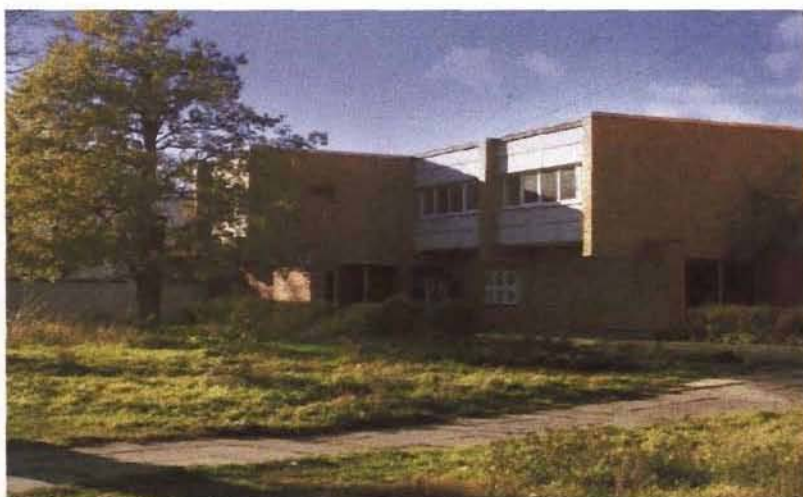
7. attēls. Rīgas Centrālās bibliotēkas Šampētera filiālbibliotēkas ēka Lielirbes ielā 6
