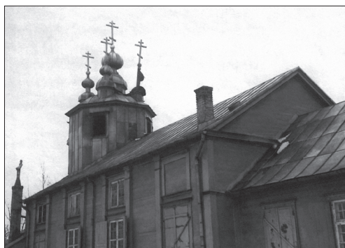
Церковь после пожара. По внешнему виду мало, что заметно – только одна маковка и развороченная крыша
