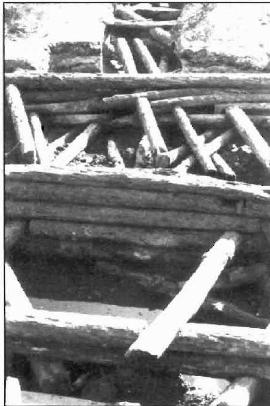
4.6. attēls. Daugavas krasta nostiprinājumu sienas ar atsaites konstrukciju pie bij. Triangula bastiona mūru paliekām
