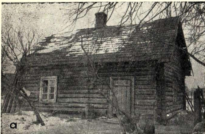
1. att. Podnieka K. Mazkalniņa dzīvojamā māja — darbnīca Lejasciemā, Kalēju ielā 6, celta 19. gs. beigās: a — kopskats; b — plāns: 1 — dzīvojamā istaba; 2 — darbnīca; 3 — trauku gludināmā flīze; 4 — dēlis mālu sagatavošanai; 5 — podnieka rīpa; 6 — dzirnavas vāpes malšanai; 7 — leēja trauku apdedzināmais ceplis; 8 — svina dedzināmais katls; 9 — maizes krāns ar mazo trauku apdedzināmo ceplīti; 10 — lielais trauku apdedzināmais ceplis; 11 — lielā cepla kurtuvju bedre.
