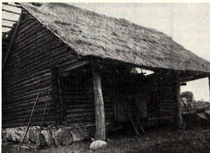
16. att. Savrupcelta kūts ar platu, uz stabiem balstītu paspārni. Rēzeknes apr. Makašēnu pag. Šķerbenieku c. Celta ap 1900. g., fotogrāfēta 1926. g. CVVM, 5423. negatīvs.
