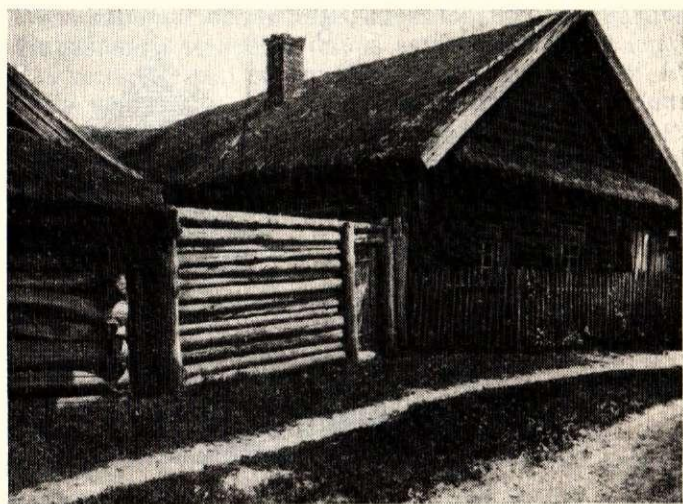
24. att. Guļkoku žogs laidara galā līdztekus apbūvē. Ludzas apr. Mērdzenes pag. Ožorgu c. Fotografēts 1926. g. CVVM, 4109. negatīvs.
