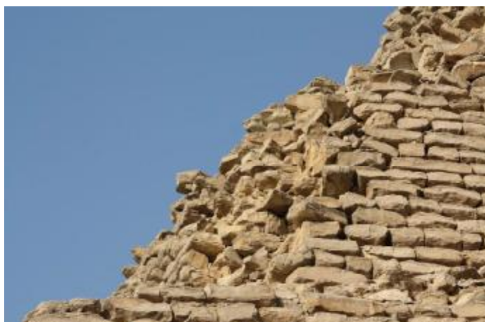
5.8. attēls. Raksturīga būvbloku kvalitāte piramīdas apakšējā daļā. Pakāpju piramīdas dienvidu fasādes otrā pakāpiena fragments. Figure 5.8. Characteristic quality of the blocks laid in the lower part of the Step Pyramid (fragment of the second step of the southern facade).
