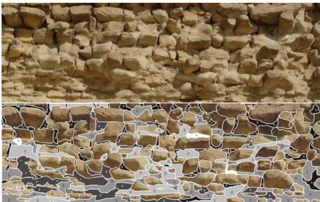
5.13. attēls. Raksturīgas kleča cementa kompozīta materiāla cementa (AC) tipa dēdēšanas atšķirības. Pakāpju piramīdas dienvidu fasāde; augšējā attēlā – parauglaukuma oriģinālais fotouzņēmums; apakšējā attēlā: 1 - 5 apzīmē cementa dēdēšanas intensitāti.
