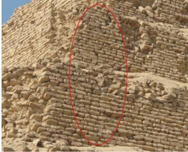
5.3. attēls. Dabā konstatēto fasādes plaisu piemērs. Austrumu fasādes 3.-4.pakāpe. Figure 5.3. Example of fissures identified on the eastern facade of the pyramid (3rd-4th step).
