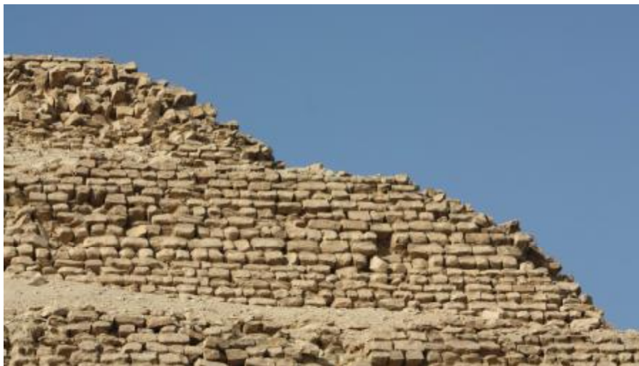
5.11. attēls. Valdnieka Džosera piramīdas noslēdzošā posma būvbloku kvalitāte (piektā un sestā pakāpiena fragments, dienvidu fasāde).
