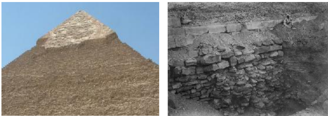
5.12. attēls. Piramīdu apšuvuma liecību piemēri. Pa kreisi - valdnieka Hefrēna piramīda Gīzā ar apšuvuma no Turas raktuvēm paliekām; pa labi – apšuvuma paliekas Džosera piramīdas austrumu fasādes apašējā daļā (Firth, Quibell, 1935, 9. att.). Figure 5.12. Examples of casing remains. On the left - the Pyramid of Khafre at Giza with the remains of casing from Tura quarry; on the right – casing on east facade of the pyramid of Djoser (Firth, Quibell, 1935, Pl. 9).
