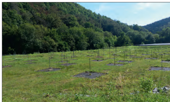
8. att. LOFAR zemo frekvenču novērošanas stacijas lauks ar dipolu antenām.
