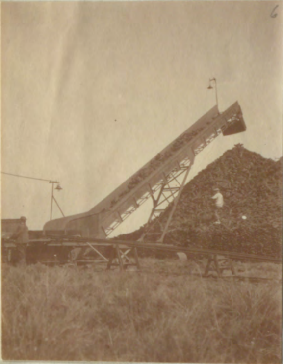
Reprise au tas pour chargement en wagons ou tombereaux
