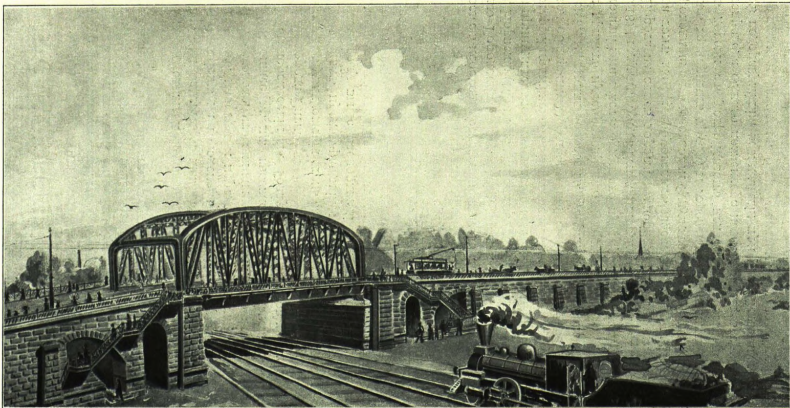
Александровскій путепроводъ въ г. Ригѣ.
