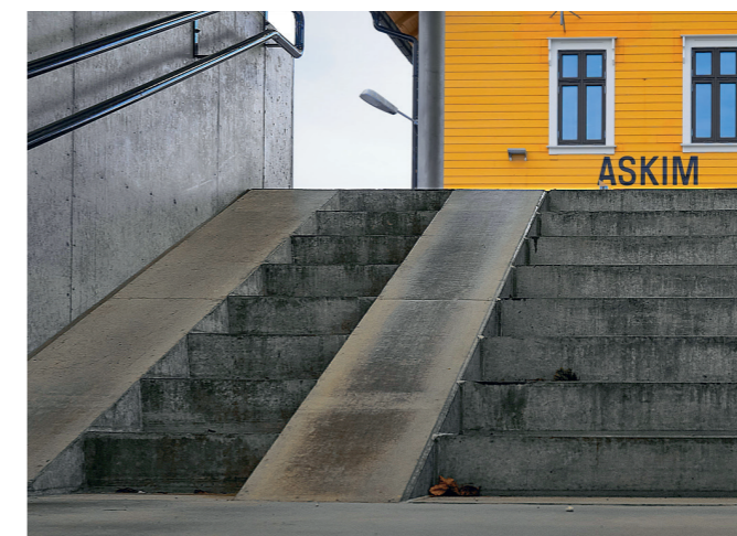
2.6. attēls. Īpaši projektēta rampa.
