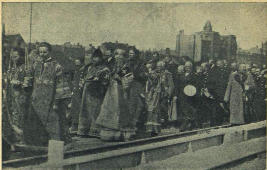
По пути через путепров. Господской улицы. — Auf dem Wege über den Viadukt der Herren-Straße. — Zetâ pahr Kungu eelas wiaduktu.
