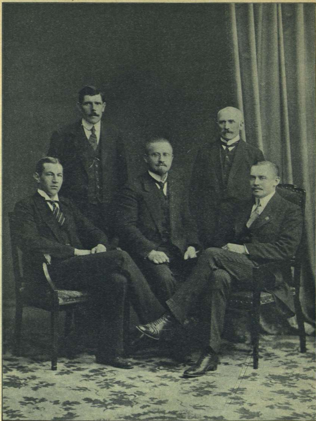
Инж. Е. Е. Беръ представитель Фирмы Вайсъ и Фрейтагъ во главѣ своего строительнаго надзора по сооруженію пассажирскихъ помѣщеній ст. Рига-Главная въ предѣлахъ землянаго полотна.
