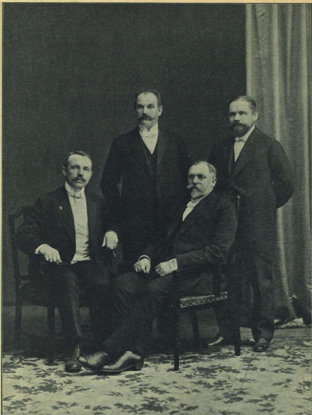
Каменныхъ дѣлъ мастеръ Х. К. Кергалвъ во главѣ своего строительнаго надзора по пострѣйки Дома Управленія Р.-О. ж. д. и буфетныхъ помѣщеній на ст. Рига-Главная.
