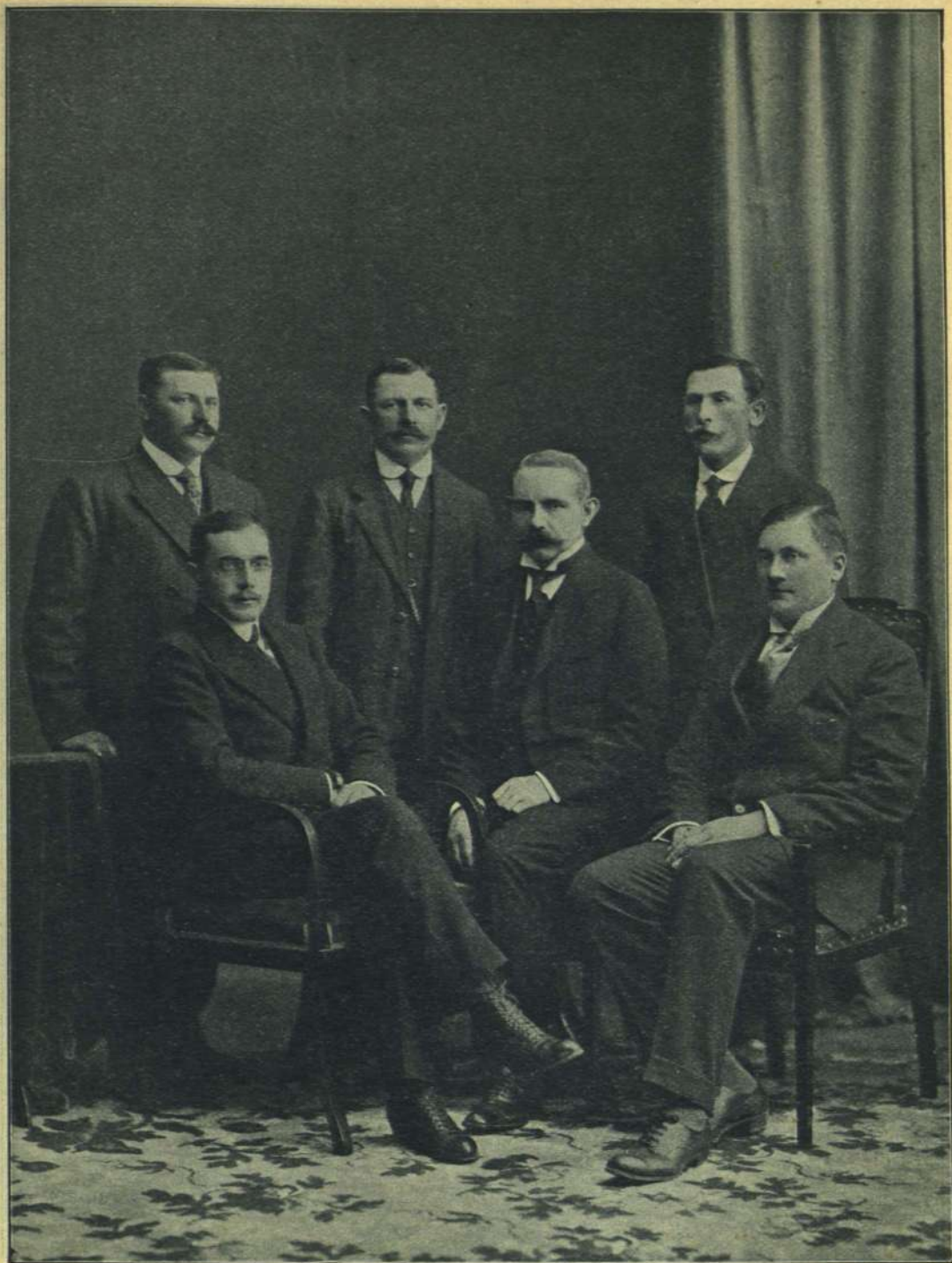
Инж. А. К. Шульцъ представитель завода Рудзскій и Ко. въ Варшавѣ во главѣ строительнаго надзора по сооруженію металлическихъ фермъ новаго ж. д. моста.
