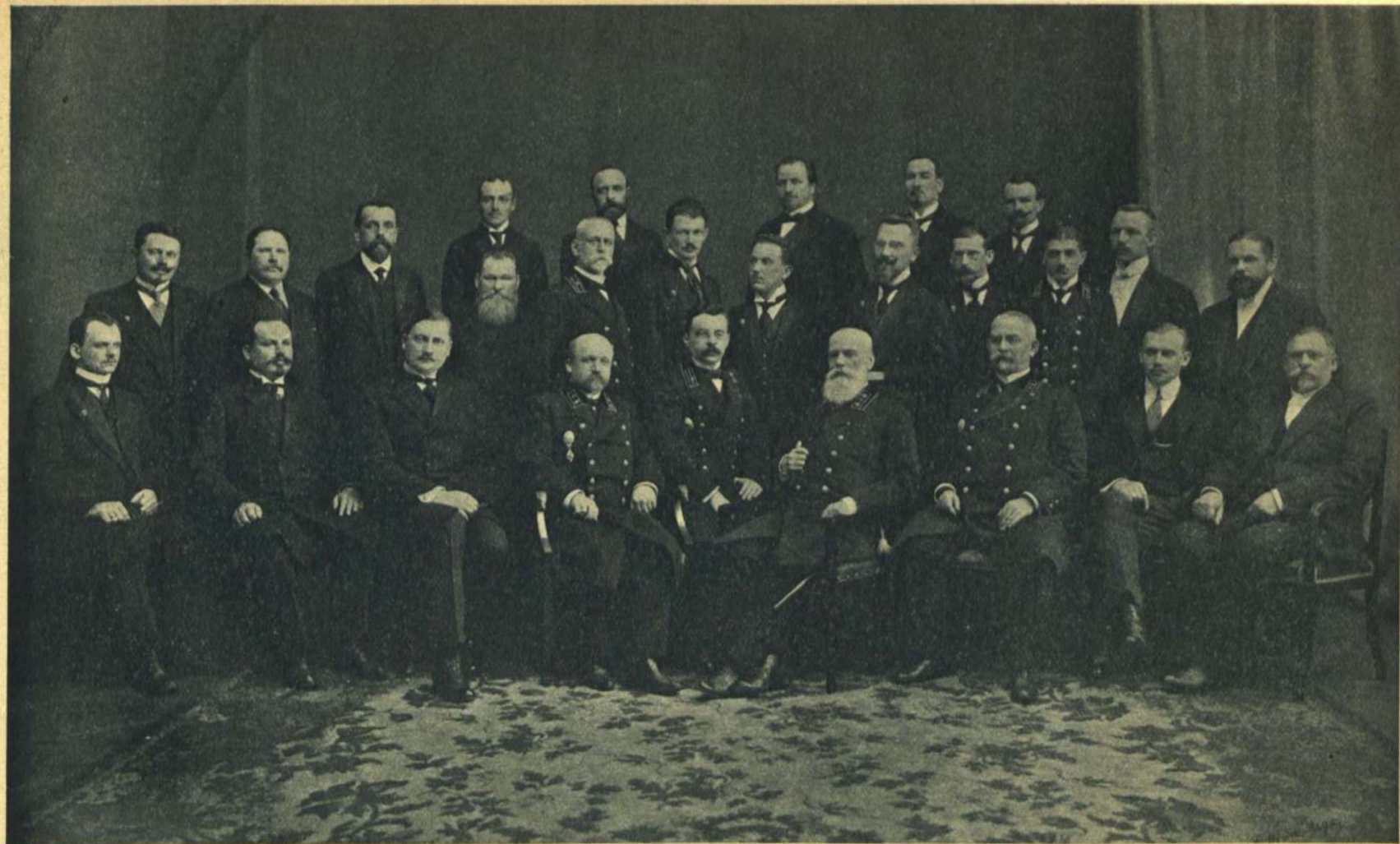
Начальникъ Риги-Орловской ж. д. дороги Инженеръ І. Ф. Дараганъ и Завѣдующій работами по переустройству Рижскаго ж. д. узла Начальникъ Сл. Пути Инженеръ А. В. Верховской во главѣ представителей технического-строительнаго надзора по постройкѣ новаго ж. д. моста и ст. Рига-Главная и г. г. Завѣдующихъ частями Службы Пути Р.-О. ж. д.
