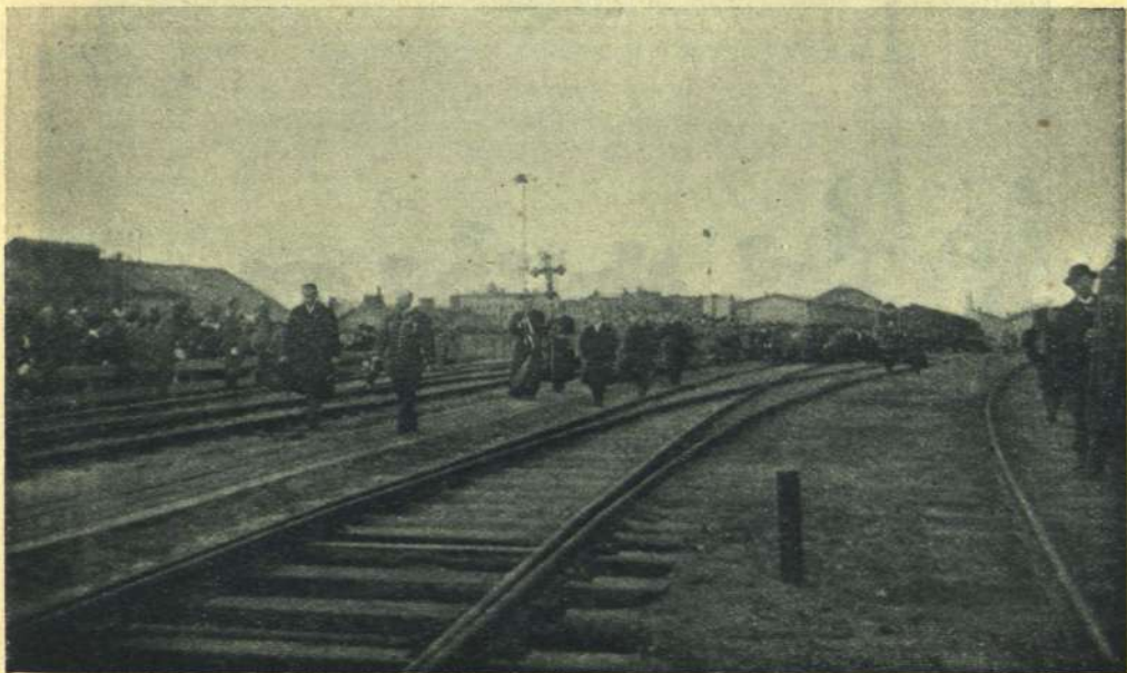
По пути черезъ путепроводъ Гоголевской улицы. — Auf dem Wege über den Viadukt der Gogol-Strasse — Zekâ pahr Gogola eelaš viaduktu.
