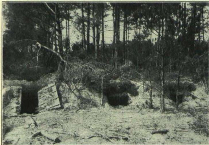
Hohlwein & Girde phot. Unterstand: links die Tür, rechts zwei Fenster
