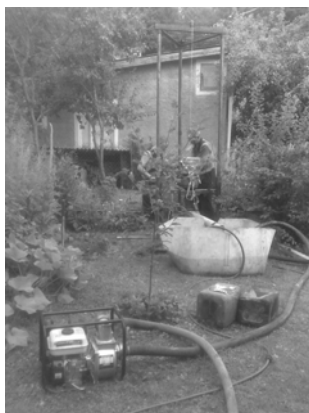
2. attēls. Mobila saliekama urbšanas ar skalošanu iekārta darbībā. Saulkrasti. Foto: J. Burlakovs, 07.2011.
