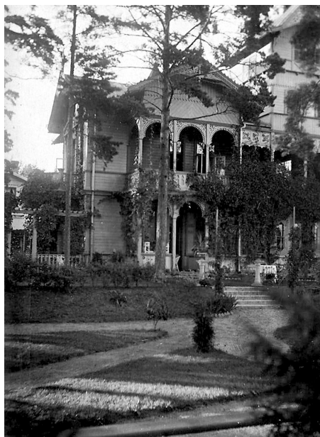
Vasarnīca Bulduru 1. līnijā Nr. 12. Ap 1905. gadu. Foto no M. Pīmaņa ģimenes privātā arhīva
