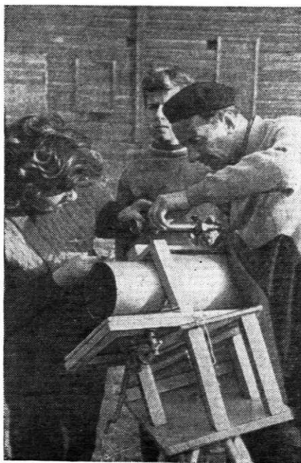
J. att. V. Magone, V. Bērenfelds un M. Dīriķis regulē fotokameru (fokusa attālums 300 mm, objektīva diametrs 67 mm).
