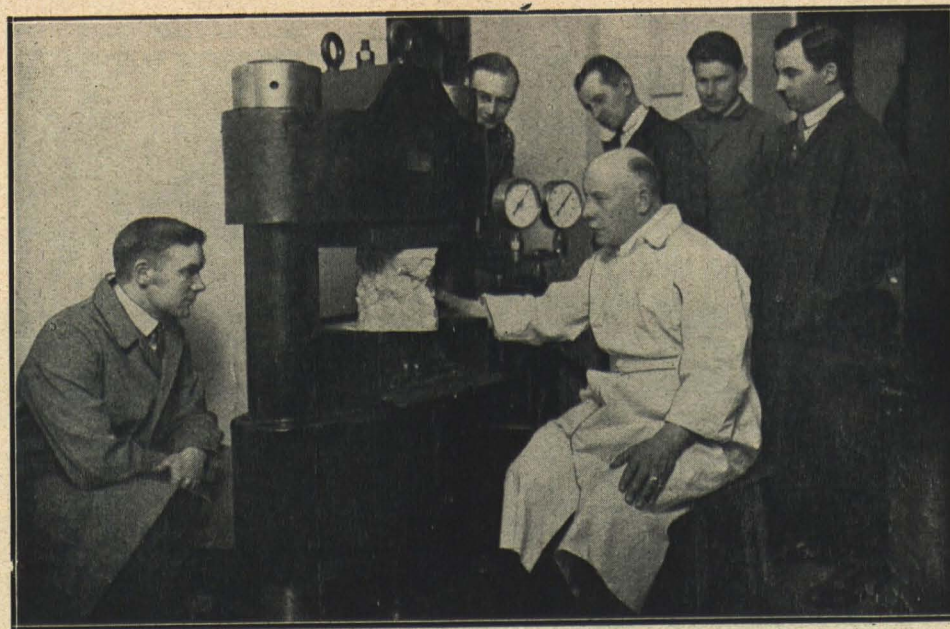
Betona izmēģināšana (300 t. hydr. spiede).
