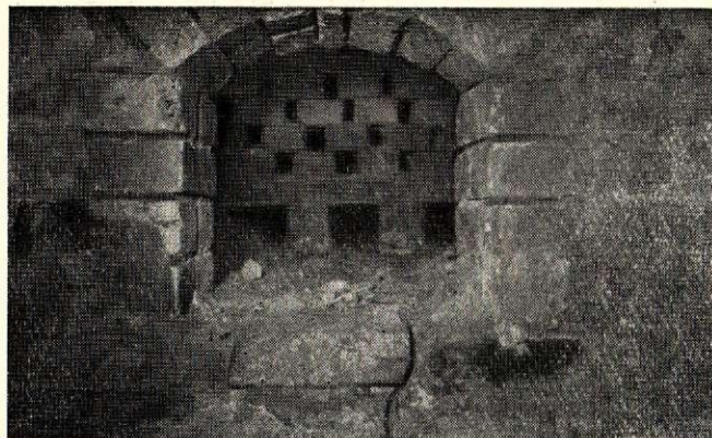
31. att. Ceplā kurtuve ar restēm, kas šķir trauku apdedzināšanas telpu no kurtuves telpas podnieka O. Grūbes darbnīcā Valkas raj. Ergemes c. p. «Stūrīšos» (E, 13, 479, 20).
