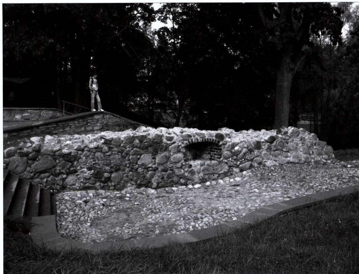
10. att. Aizsargmūra daļa ar šaujamlūku un bruģētā ceļa posms pēc restaurācijas
