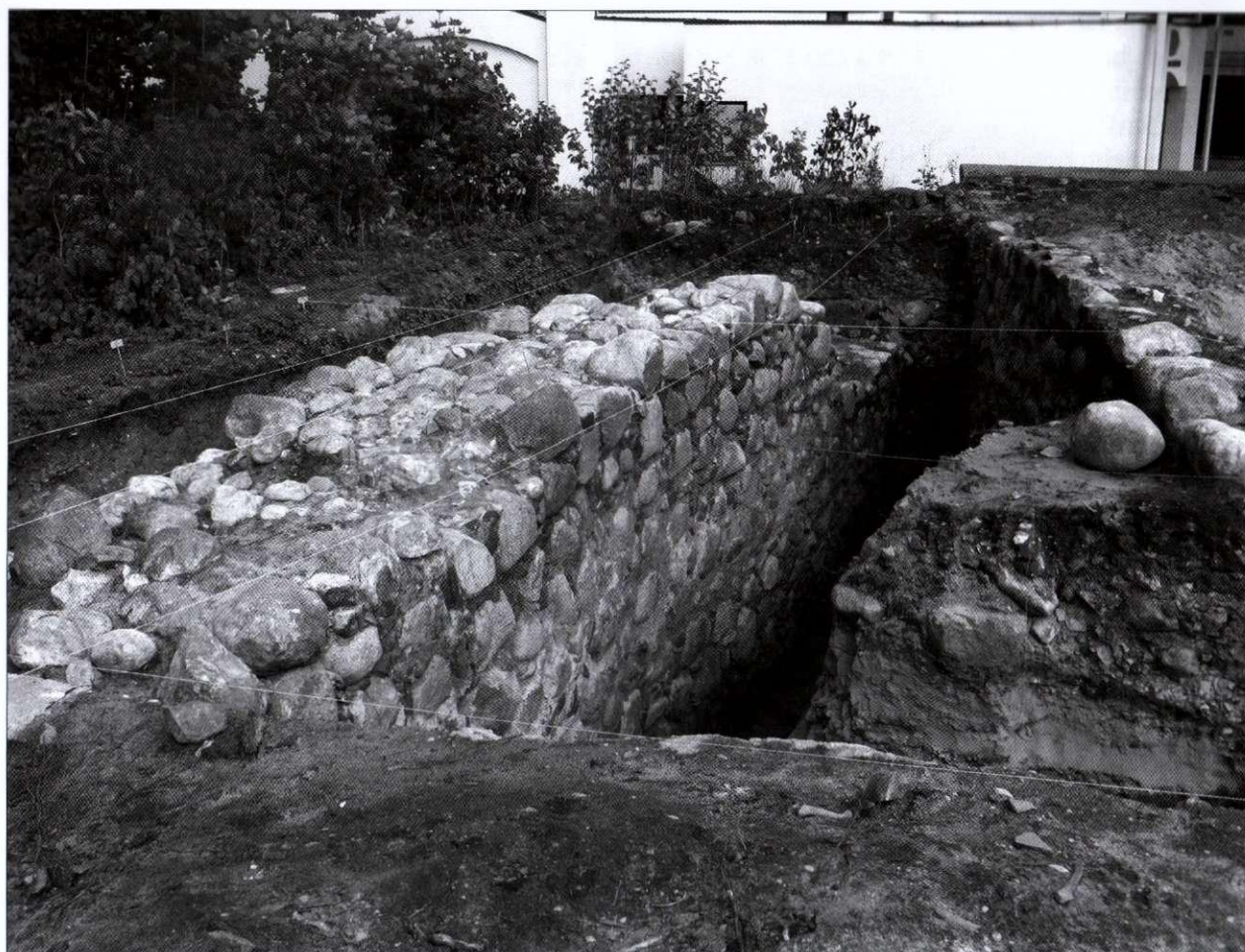
11. att. Ziemeļu aizsargmūra gals blakus Tērbatas vārtu vietai
