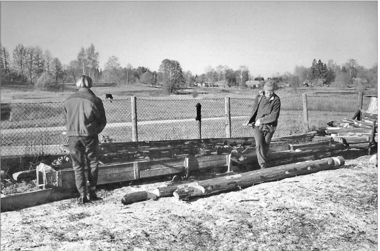
7. att. Būvkoķu piesūcināšana vannā būvlaukumā. No kreisās: E. Žīgurs, A. Vanags. J. Apala foto, 1996
