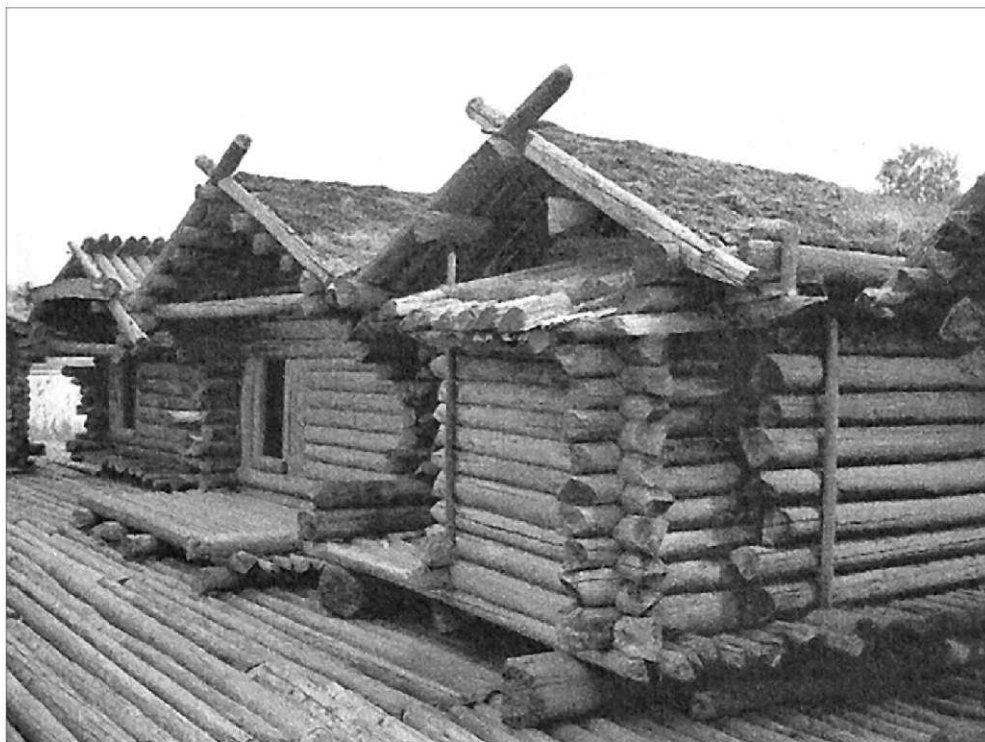
8. att. 112. un 113. ēka rekonstrukcijas apbūvē. J. Apala foto
