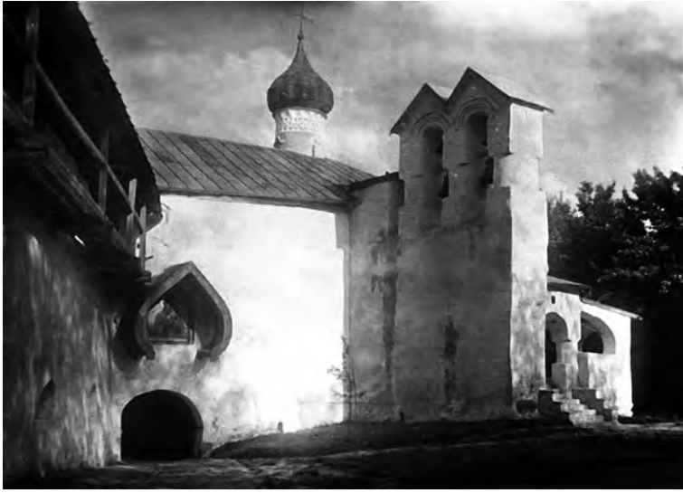
Никольская церковь после реставрации звонницы. Фотография В. Шервинского
