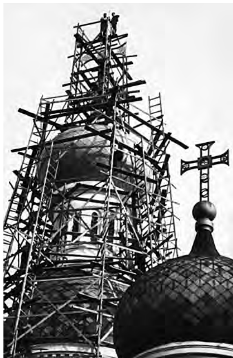
Установка центрального креста Иоанновской церкви. Фотография В. Шервинского
