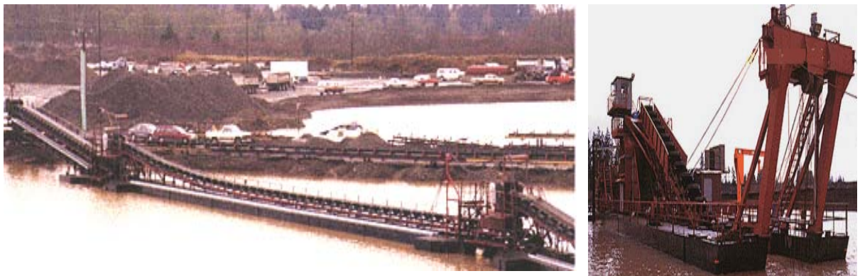
2.31. att. Līnija uz peldošā ekskavatora
