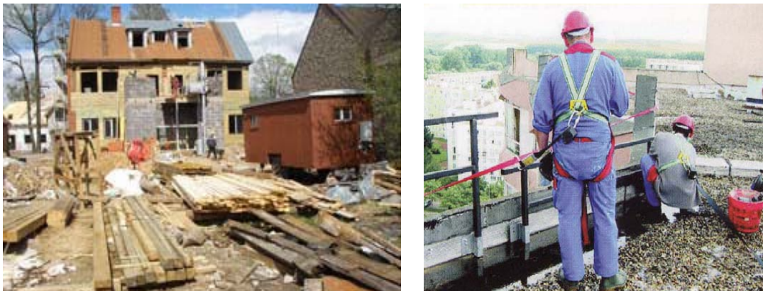
2.33. att. Būvobjektu demontāžas procesa piemērs
