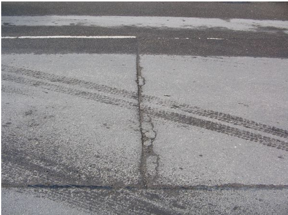
P2.4. att. Ceļa bojājumu klases plaisa paraugs. Laiks 24.03.2011 14:18, koordinātes N 56:58.871 E 024:11.526
