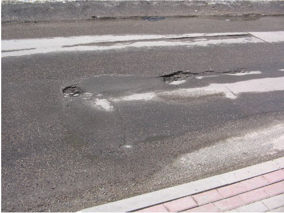
P2.3. att. Ceļa bojājumu klases bedru klāsteris paraugs. Laiks 24.03.2011 14:19, koordinātes N 56:58.880 E 024:11.527
