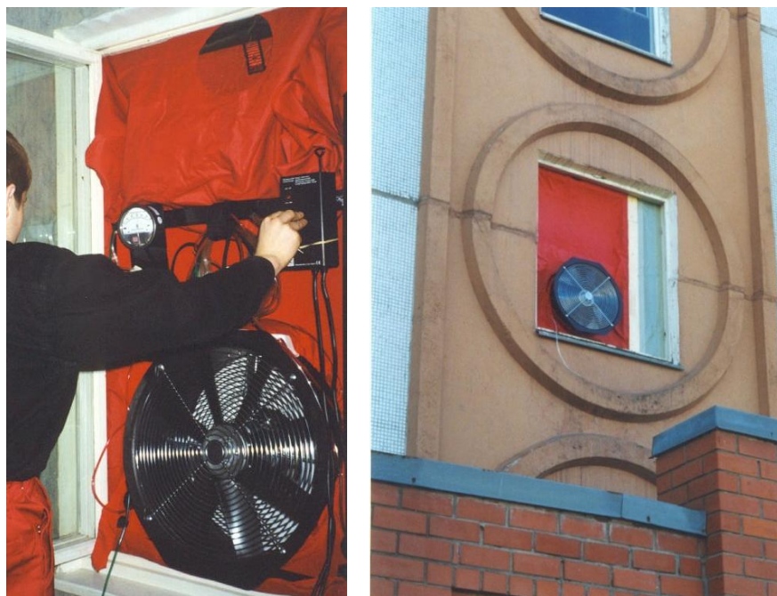
Attēls 2.103. Logā ievietotās BlowerDoor iekārtas kopskats mērījumu laikā.
