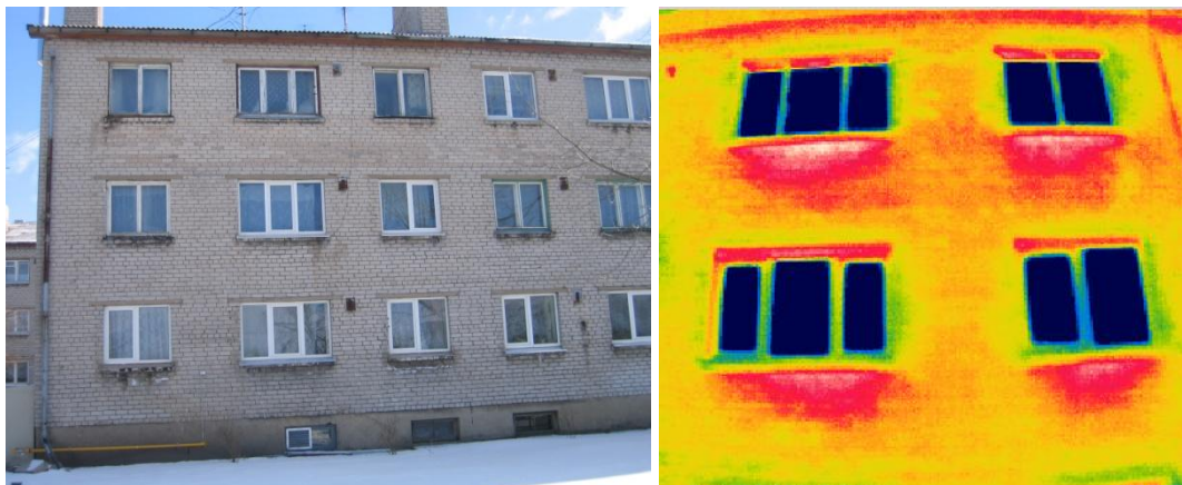
Attēls 3.12. Modelējamā 318. sērijas daudzdzīvokļu māja (pa kreisi) un termogrāfiskais ār sienas uzņēmums ar paaugstinātu virsmas temperatūru radiatoru novietojumu vietās (pa labi).
