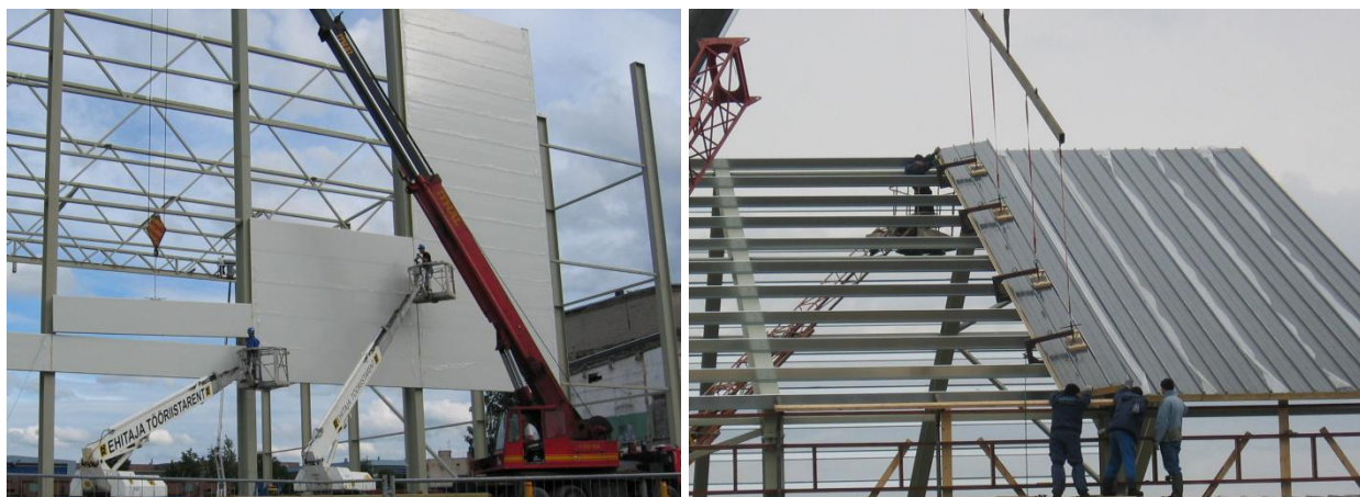
Attēls 2.90. Celtniecības paneļu piestiprināšana pie ārējas un jumta nesošiem karkasiem.
