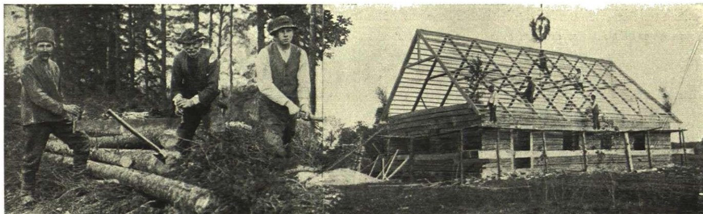
Ferme en construction.
