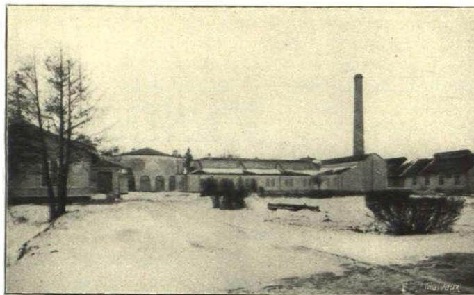
Vue générale des installations thermales.
