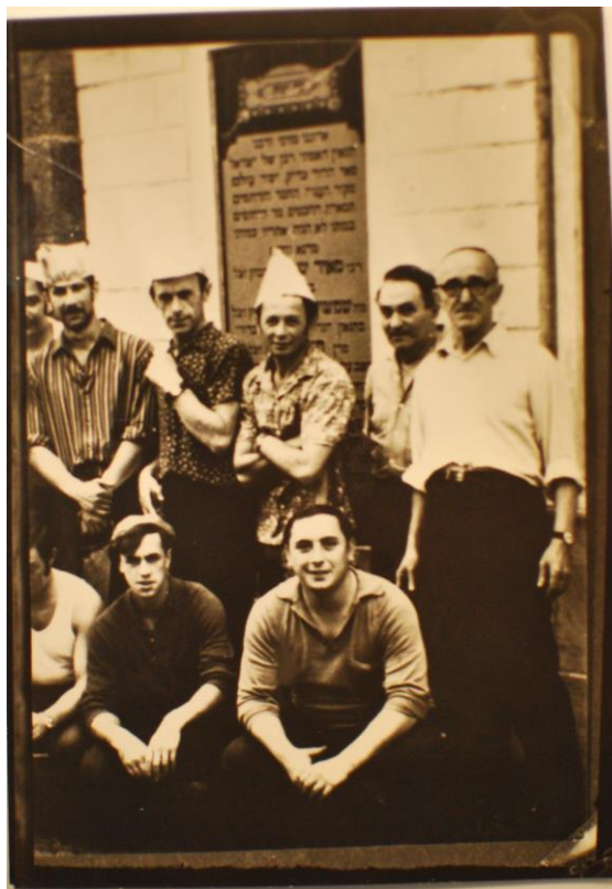
3.16. att. Brīvprātīgie Daugavpils Ebreju kapsētas pārapbedīšanas darbos. 30
