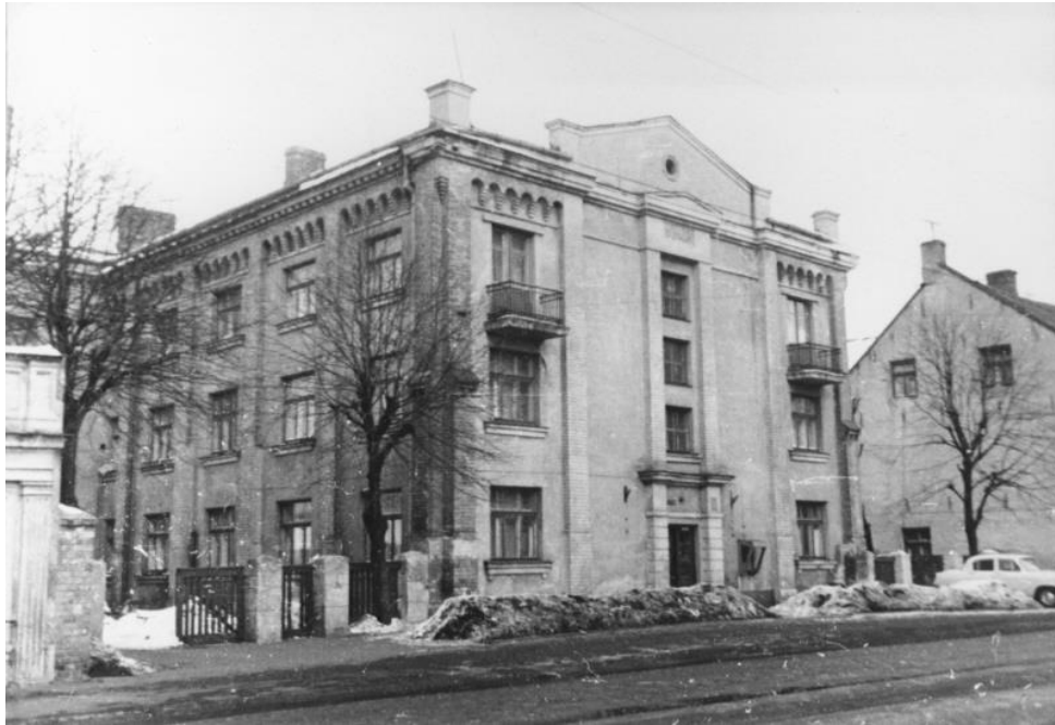
3.15. att. Kādreizējā sinagogas ēka Rīgā (mūsdienās Maskavas ielā 57), pēc 1945.g. 29
