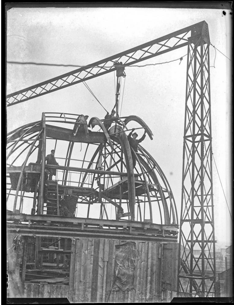
4. attēls. Teleskopa kupola montāža.
