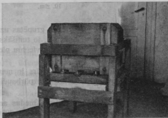
C. Krāns aizsargāts ar pieskrūvētu dēli — pa pār- vadāšanas laiku.
