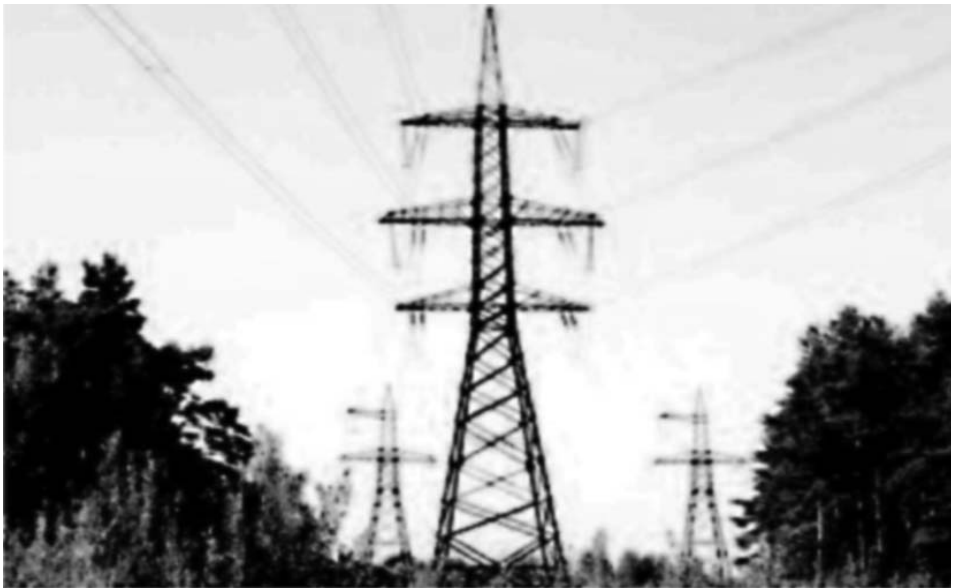
4. attēls. Augstsprieguma elektrolīniju aizsardzības zonās augoši krūmi un koki (15) High Voltage Electric Line Protected Area Growing Bushes and Trees
