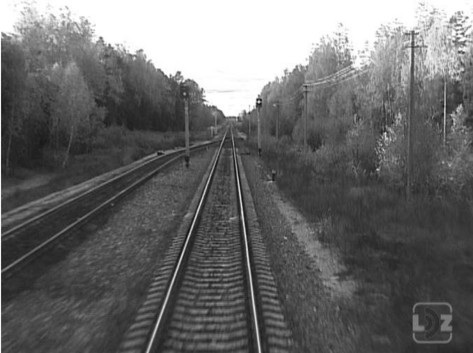
5. attēls. Augoši krūmi un koki dzelzceļa līniju aizsardzības zonās (10) Railroad Track Protected Area Growing Bushes and Trees
