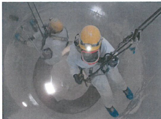
3.18.att. Cementa silosu tīrīšana
