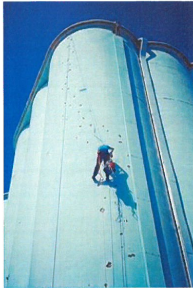
3.21.att. Cementa silosa tīrīšana no ārpuses
