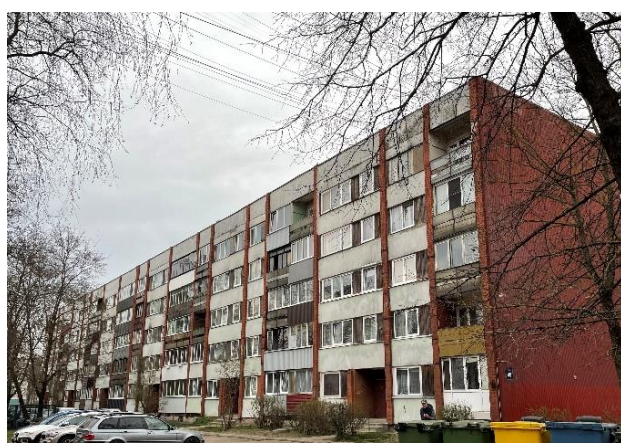
103. sērijas daudzdzīvokļu ēka (1966. – 1975. gados celta) Birzes ielā Daugavgrīvē
