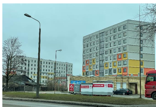
Pēc 1996. gada uzcelta sociālā daudzdzīvokļu māja Mežrozīšu ielā Bolderājā
