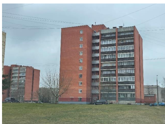
Čehu projekta 9 stāvu ēka (1976. – 1995. gados celta) Finieru ielā Bolderājā
