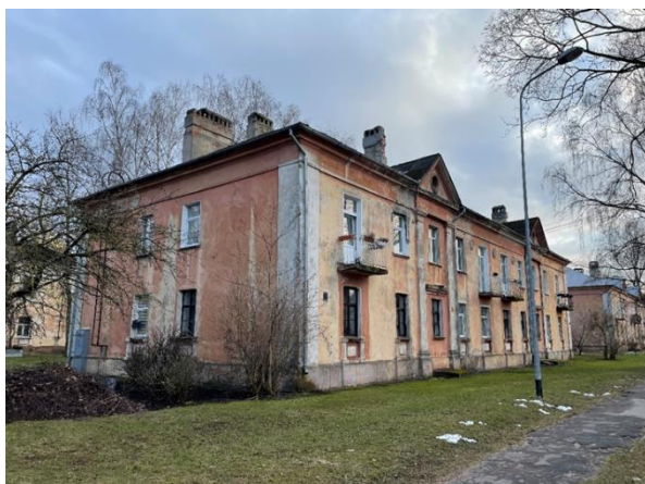
Staļina laika (1946. – 1955. gados celta) ēka Slimnīcas ielā Daugavgrīvē.
