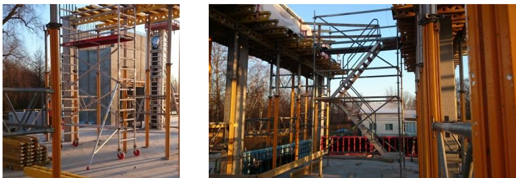
1.18. att. Pārvietojamie torņi būvobjektā Kundziņsalā (autores foto)
