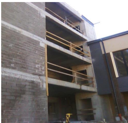
1.10. att. Sienu aiļu nožogojums būvobjektā Jelgavā (autores foto)
