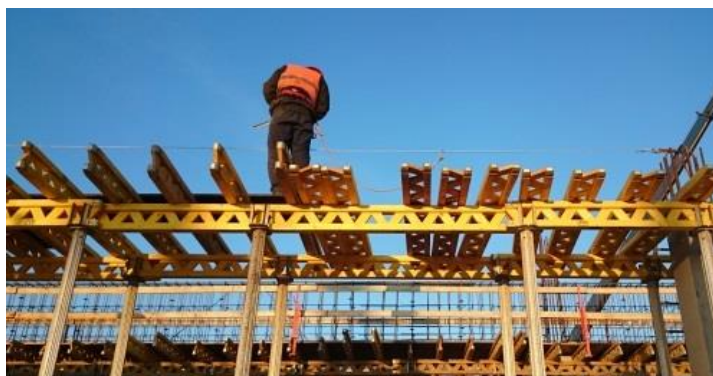
1.20. att. PAS stiprinājums būvobjektā Kundziņsalā (autores foto)
