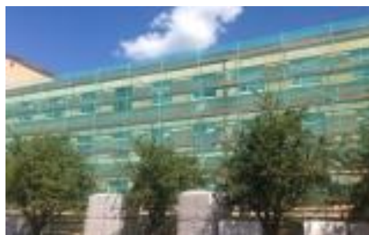
1.13. att. Kritienu novērsošie sastatņu vertikālie tīkli (foto no interneta: [ http://bgnoma.lv/lv/top/BG+Noma+Sakums/ ])
