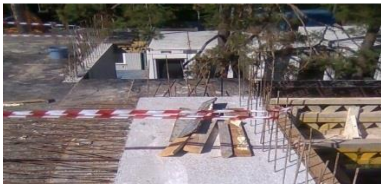
1.12. att. Bīstamas darba zonas norobežojums un apzīmējums būvobjektā Jūrmalā (autores foto)
