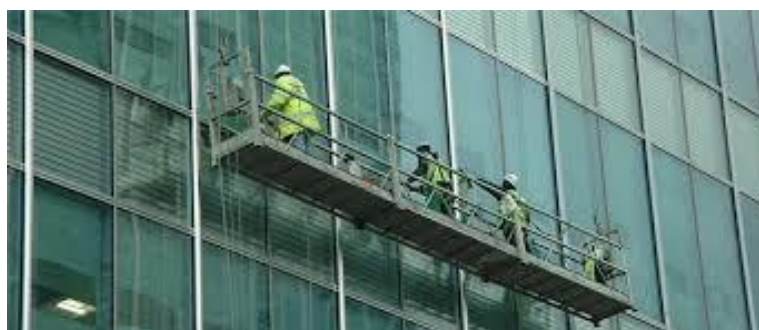
1.17. att. Piekarsastatne ar aizsargnožogojumu (foto no interneta [39])
