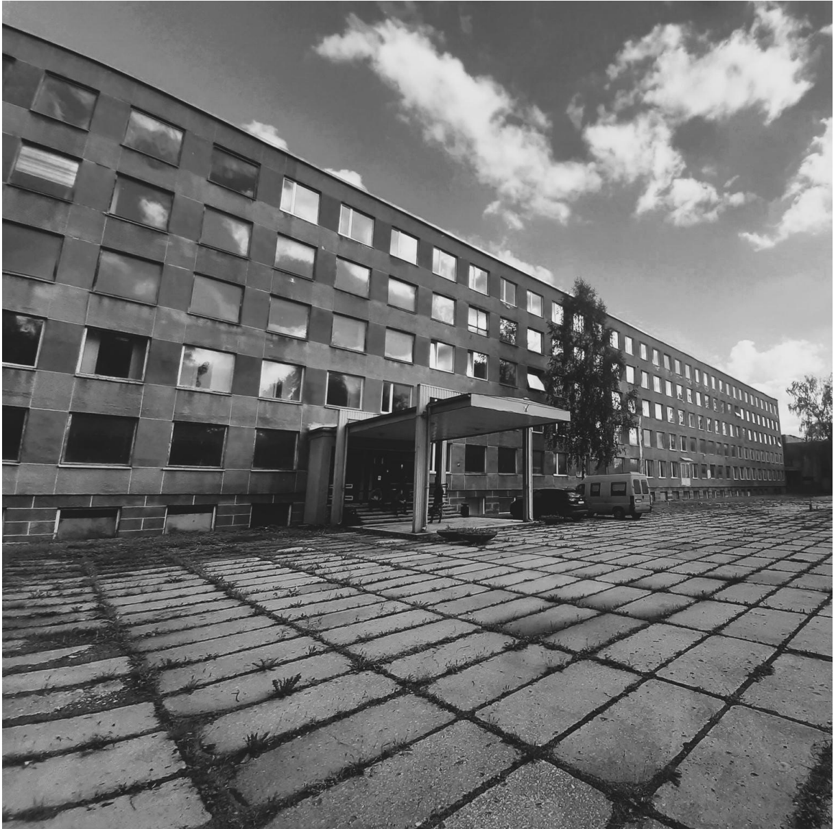
Photo 4.1.1. “Viskaļi” building in 2020 (Viskaļi – Dzīves kvalitātes dizaina institūts, 2021)
