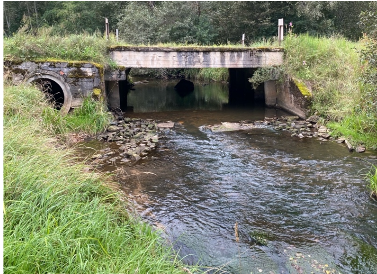
3.2. attēls. Caurteka un tilts pār Vaives upi pie Dārza ielas Priekuļos (6. posms, upes vidustece).
