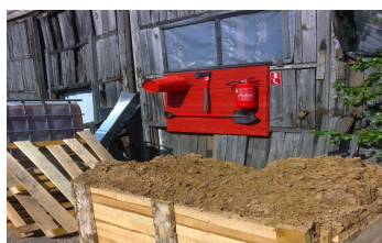
1.2.6. att., Ugunsdrošības aprīkojums
