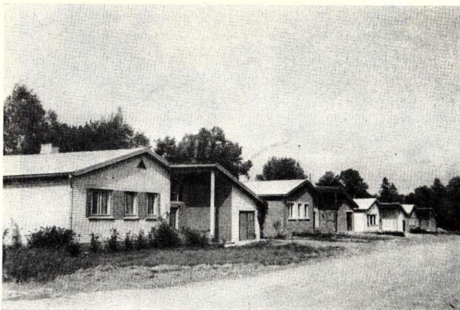
2. att. Dzīvokļu celtniecības kooperatīva 70. gados celtās viengimenes dzīvojamās mājas Tukuma rajona kolhoza «Dzimtene» centrālajā ciematā Tumē.
