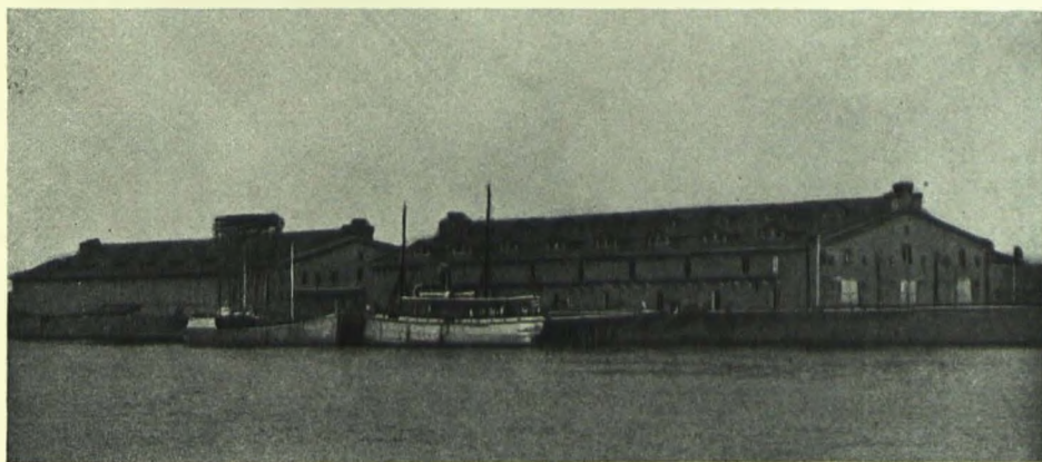
Амбары Николаевской желѣзной дороги на лѣвомъ берегу Морского канала.
