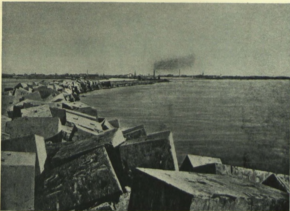
Южный молъ (часть мола, построенная изъ наброски массивовъ).
