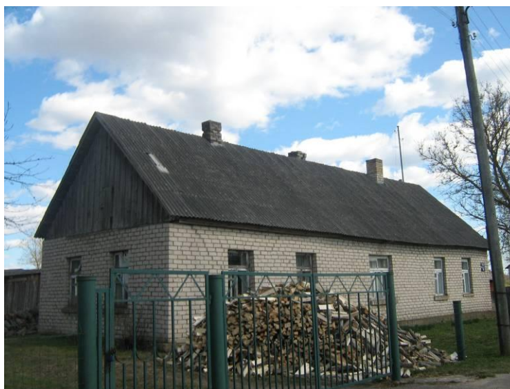
4.4.1. 1.att. Riebiņu pareizticīgo draudzei piederošā dzīvojamā māja (autora foto, Riebiņu,2010)
