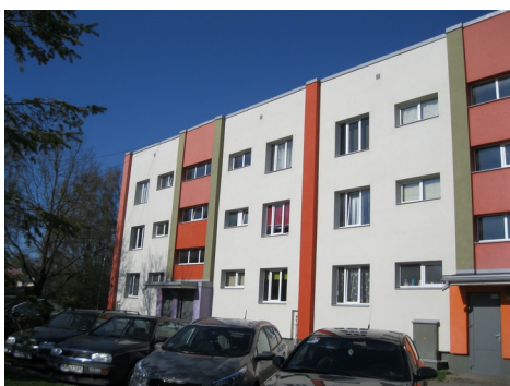
3.2.2.1. attēls. Renovēts daudzdzīvokļu nams Jaunmārupē (autora foto)
