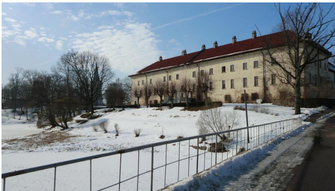
18.attēls. Dundagas pils, skats no parka (Pils ielas) tilta (06.03.2013) (no autores personīgā arhīva).
