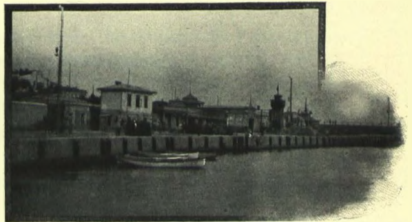
Сѣверная набережная. Склады и конторы пароходныхъ обществъ.
