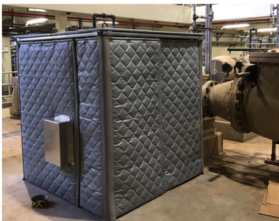
4.7. att. Iekārtas radītā trokšņa izolācija to izcelsmes vietā [134]
