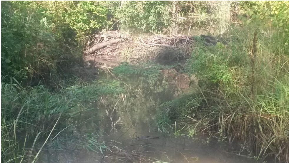
6.attēls. Bebru dambja uzpludināts posms Krāčupītē
