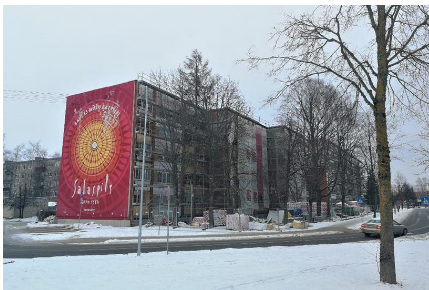
7.10. attēls. Uzsākti renovācijas darbi daudzdzīvokļu dzīvojamajai ēkai Skolas ielā 5/2 (HES ciemats)
