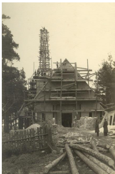
4.2.att. Viesītes Brīvības baznīcas celtniecība 30 gados. (Foto no Viesītes bibliotēkas albuma)
