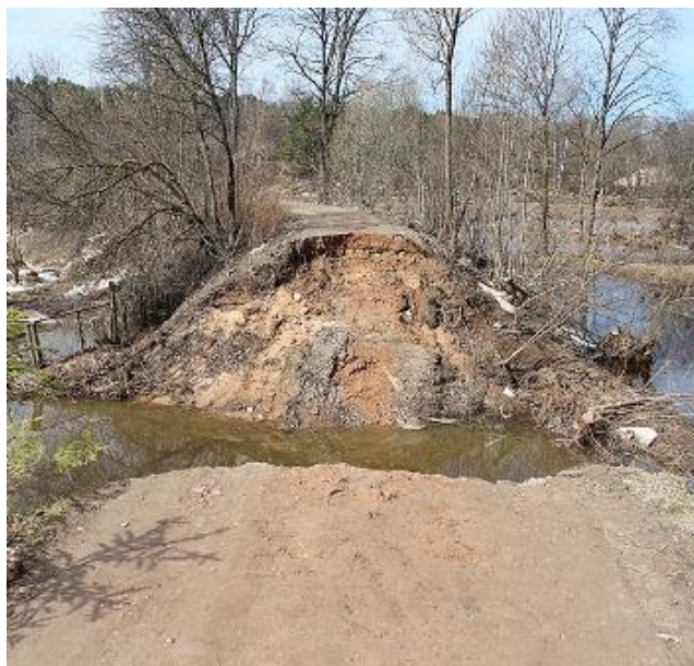
3.2. attēls. Vecā dambja pārrāvums pie Norupītes ietekas Ogres upē 2013. gada plūdu epizodē (SIA Jurēvičs un partneri, 2013)
