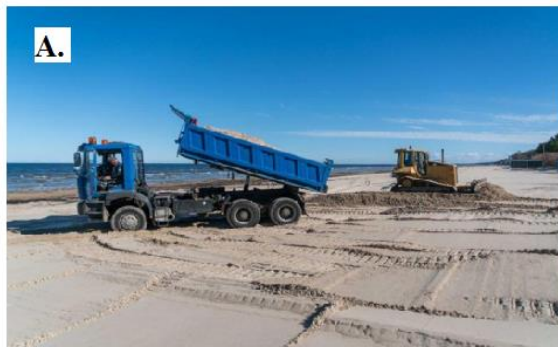
1.8. attēls. Pludmales barošana Majoru pludmalē (A.) Kārķu pinumu sētiņu izveide Kauguru pludmalē (B.) (Foto A. Soms)
