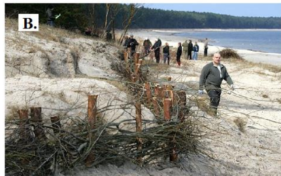
1.8. attēls. Pludmales barošana Majoru pludmalē (A.) Kārķu pinumu sētiņu izveide Kauguru pludmalē (B.) (Foto A. Soms)
