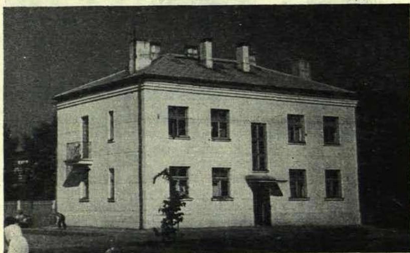
20. attēls. 301-1 tipu ēkas Rīgā, Ziepniekkalna ielā.
