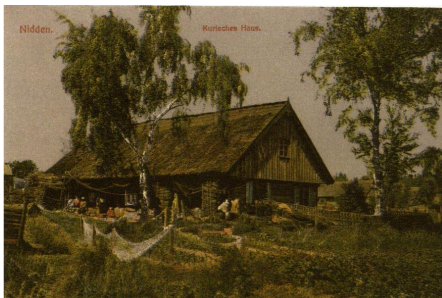
7. att. Zvejnieku sēta Nidas ziemeļu daļā. Dzīvojamai ēkai zelmiņa vējdēļu krustpunktā dzīvības koks, priekšplānā kārtis tiklu žāvēšanai un sakņu dārziņš (Demereckas 2012: 191).
