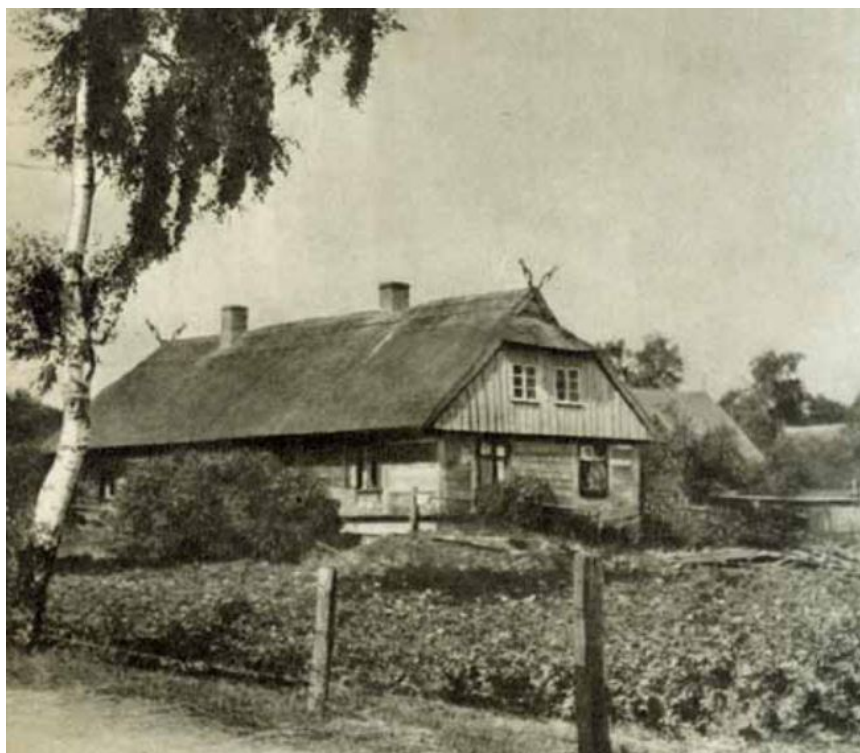
10. att. Divu pilnu galu dzīvojamā ēka Nidā. Jumts ar nošļautiem galiem, stāga gaiļiem, niedru jumtu (Demereckas 2011: 217).
