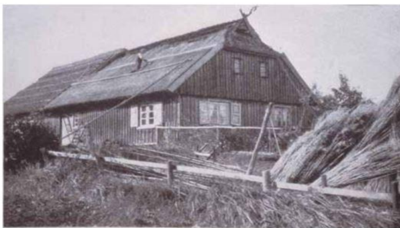
9. att. Dzīvojamā ēka ar niedru jumtu, nošļautiem jumta galiem, štāga gaiļiem, bez skursteņa 19. gs. beigās Nidā (Demereckas 2011: 216).
