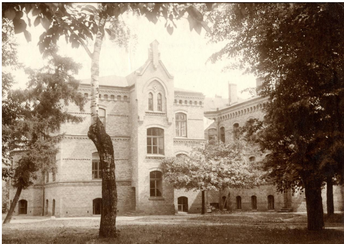
2.1. att. Rīgas 1. slimnīcas Dzemdību un ginekoloģijas klīnikas ēka, 20. gs. sākums 418
